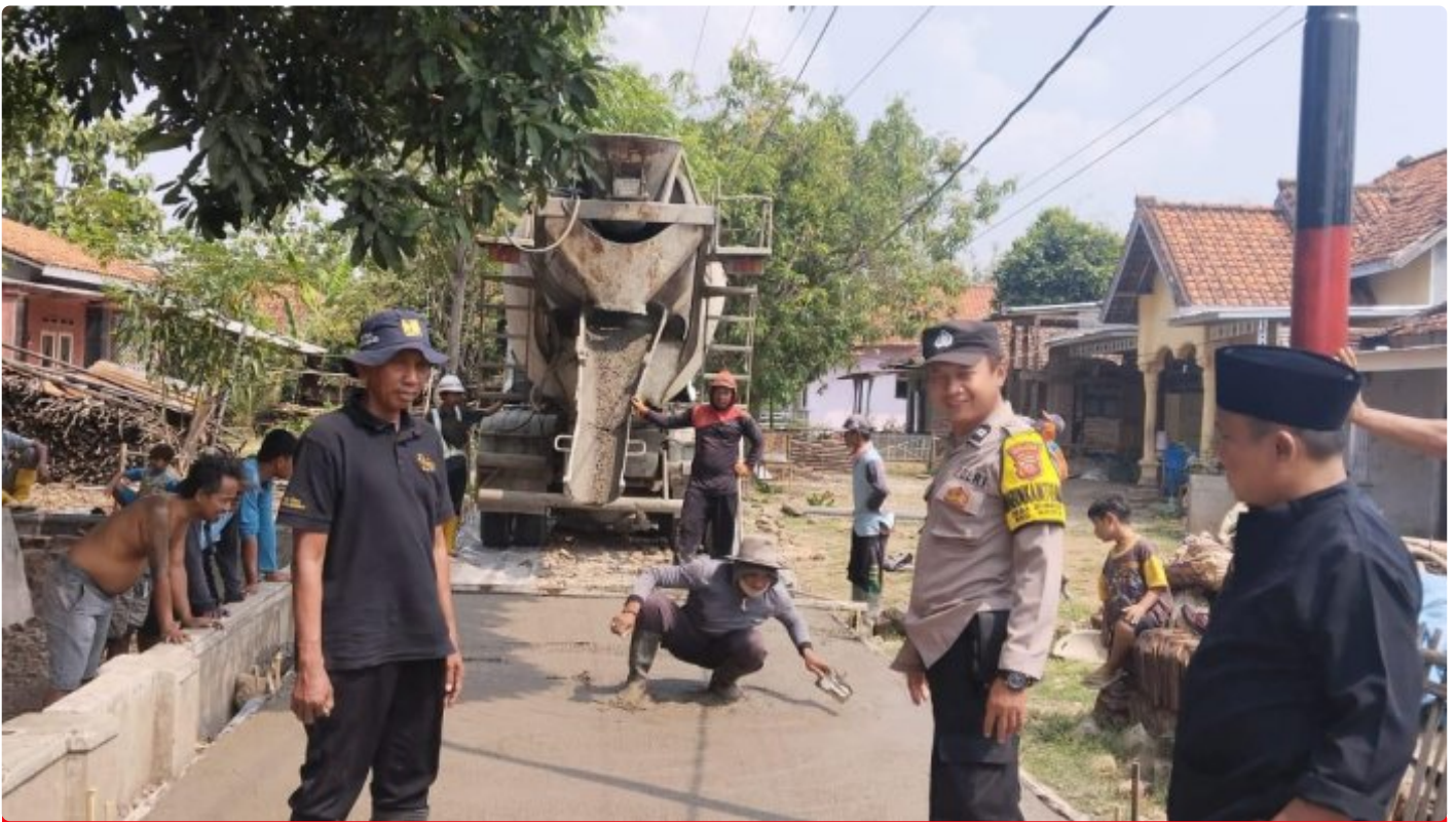
Bhabinkamtibmas Polsek Kroya Laksanakan Monitoring Pengecoran Jalan Di Desa Sumbon
