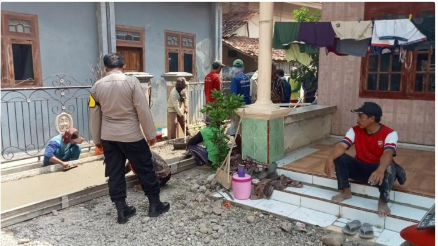
Bhabinkamtibmas Polsek Lohbener Memantau Progres Pembangunan Jalan Setapak
